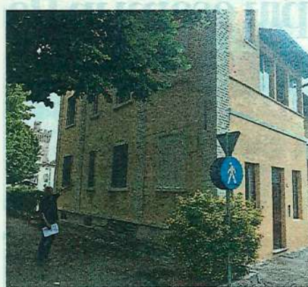
La palazzina in via Molinazzo che ospita sette alloggi del Comune
